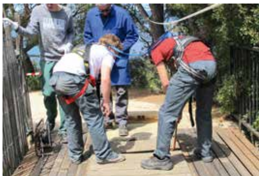
Des travaux pratiques « sur le terrain » complètent la formation en atelier
